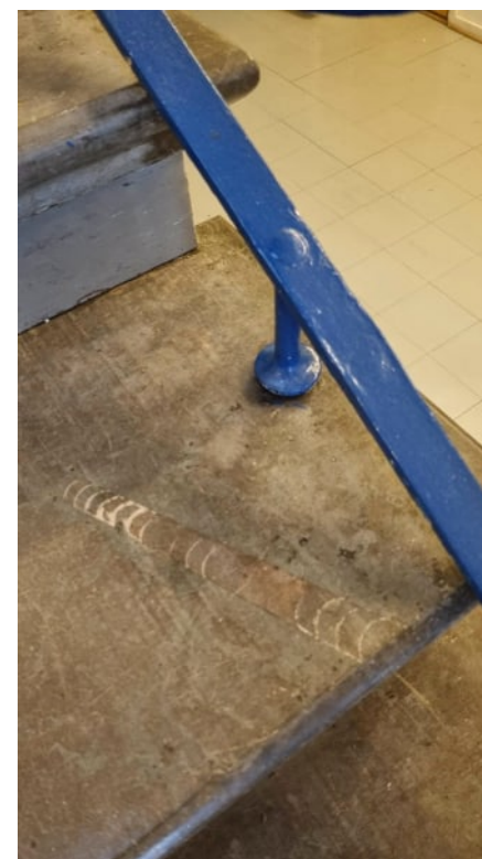
PORTAIKKO Rakennusten portaitkoissa on pääosin alkuperäiset askelmat. Niissä on näkyvissä fossiileita.
